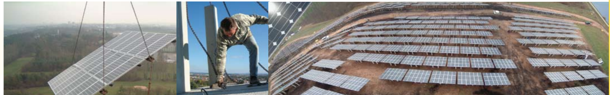
Bauphase der 1-Megawatt-Photovoltaik-Netzanlage (Müllberg, Fürth)
