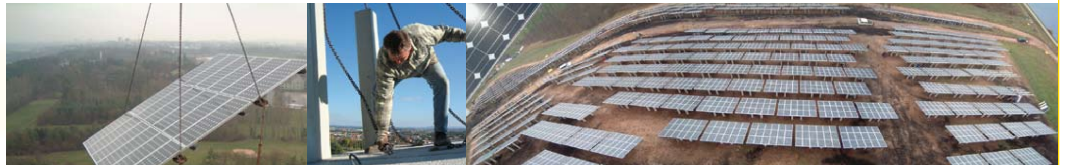
Bauphase der 1-Megawatt-Photovoltaik- Netzanlage (Müllberg, Fürth)
